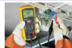
Contrôle de câblage pour boîtes de dérivation de petite taille - tout en un
