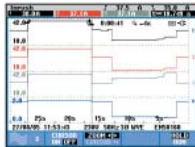
Figure 4 : diagramme de tendance montrant le courant de démarrage récurrent causé par l'apparition d'une charge forte à faible impédance au sein du commissariat central d'Eindhoven.
